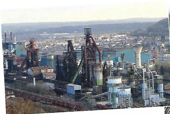
1 L'usine sidérurgique fermée de Florange (Moselle), 2013
